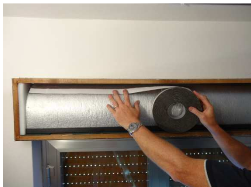
applicare il nastro biadesivo
