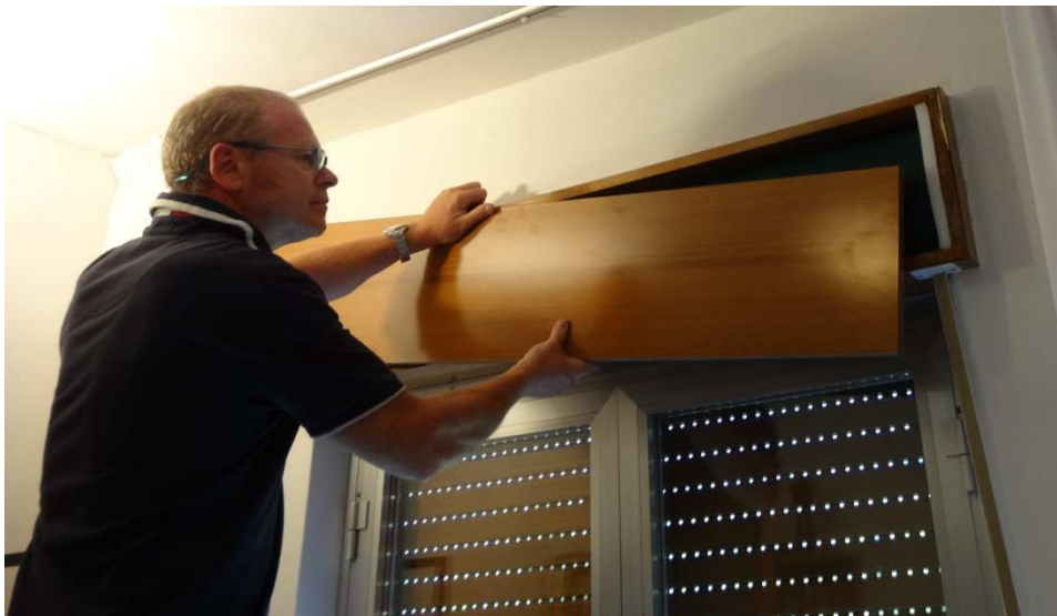
posizionare e fissare il celino di chiusura
