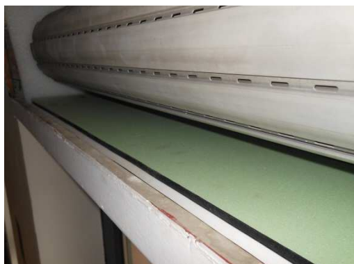
inserire la barra di contenimento inferiore ed il pannello isolante Termopav
