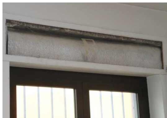
inserire il pannello frontale Flexoterm
