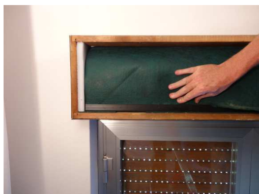
infilarlo nella barra di contenimento inferiore
