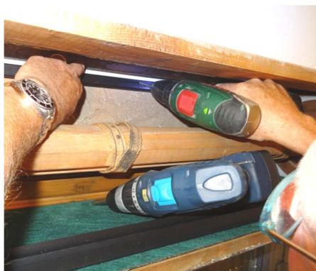
tenere la barra sul muro e forare
