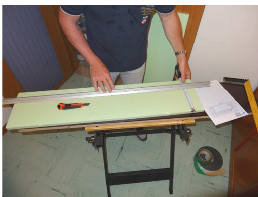
tagliare il Termopav
