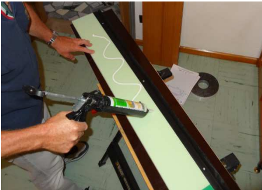
applicare l'MS polimero sul retro del pannello e posizionarlo sul fondo del cassonetto
