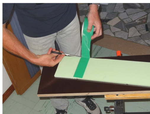
giuntare eventualmente il Termopav con il nastro di tenuta
