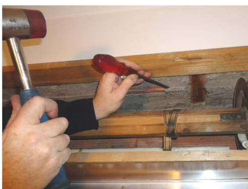
togliere le scabrosità che potrebbero ostacolare l'inserimento del pannello
