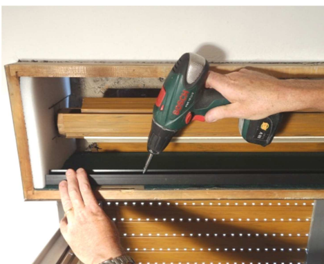
posizionarla senza occludere il sistema di chiusura del celino
