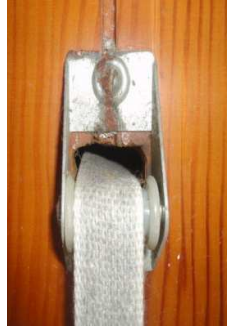
Differenza di tenuta all'aria tra il vecchio ed in nuovo guidacinghia
