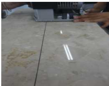
Lo scanalatore inizia il lavoro
