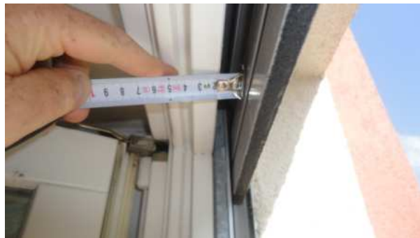
Lo Spazio tra l'avvolgibile ed il serramento in questo caso è di 2,5 cm
