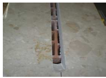
Risultato finale dopo l'asportazione della striscia tagliata. Lo spazio va riempito con schiuma o altro materiale isolante
