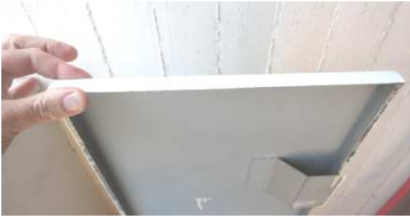
Celino in lamiera piegata da 6/10 di mm
